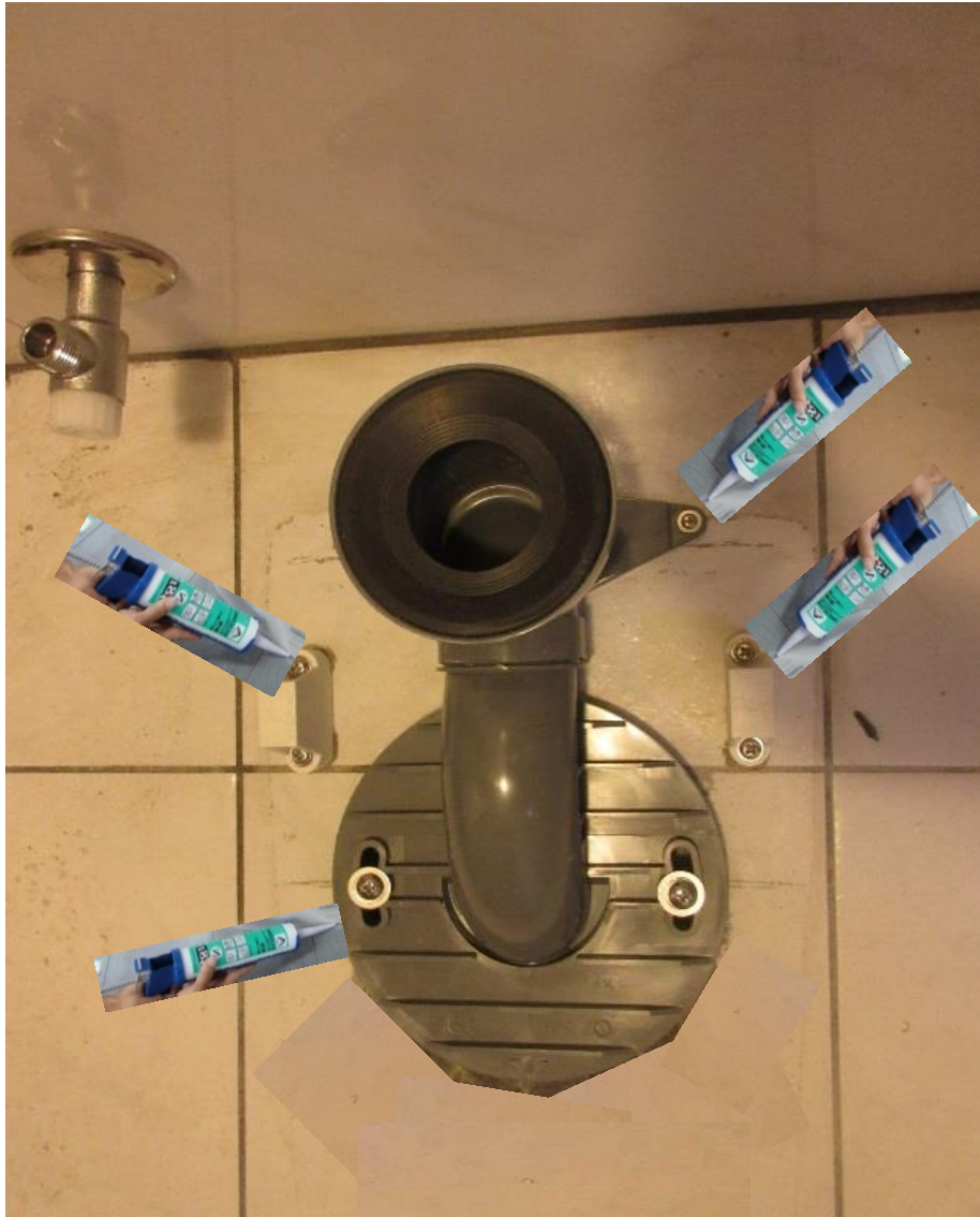
1. 套管組邊緣及固定塊打上矽力康。
