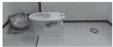
②將施工板放置在馬桶後側的**馬桶安裝孔**上。
