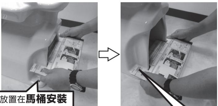
③在施工板上畫上**左右**的馬桶安裝孔中心記號。
